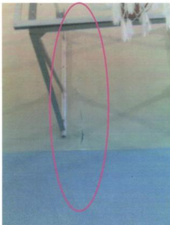
Фото 10. На 3-ем этаже Лит. А обнаружена трещина в шве заделки между плитами перекрытия по оси «5'» в районе оси «В» и в наружной стене по оси 5' шириной раскрытия до 1,5мм.
